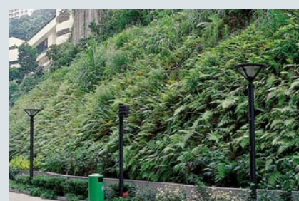
Mái taluy gia cố bằng lưới thép với bề mặt cỏ mọc tốt sau khi thi công (Hong Kong)
