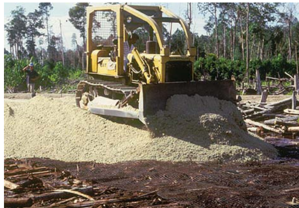
Thi công đường sử dụng hệ thống truyền tải trọng trên nền đất bùn (Indonesia)
