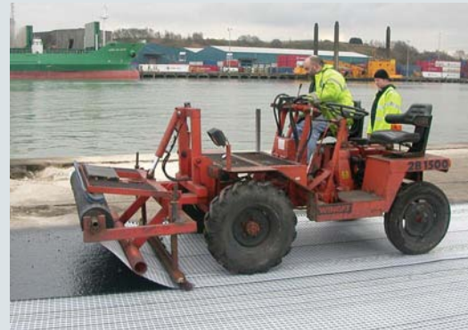
Thiết bị lắp đặt lớp vật liệu gia cố
