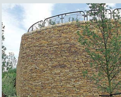
Bề mặt tường đá xây
