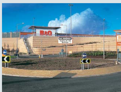
Tường chắn trong giai đoạn thi công
