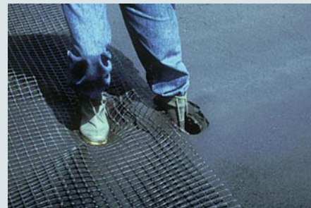
Thi công an toàn
