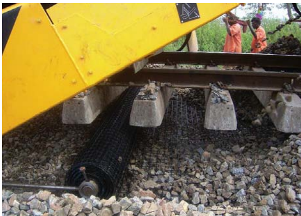
Có thể dùng lưới địa Tensar trong công tác rửa đường ray (Đức)
