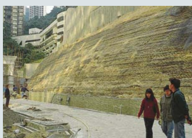
Mái taluy có bề mặt hình thành từ các bao đất trước khi cỏ mọc che phủ
