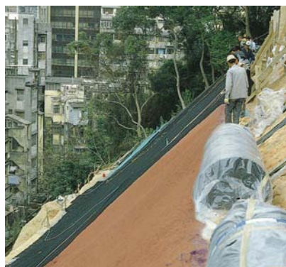
Mái taluy dốc đứng trồng cỏ sử dụng lưới Tensar Mat
