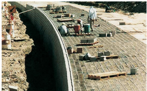
Công trình này ở Các Tiểu Vương Quốc Ả Rập Thống Nhất cho thấy rằng có thể xây Hệ Tường TW1 Tensartech mà không cần cầu hoặc thanh chống.
