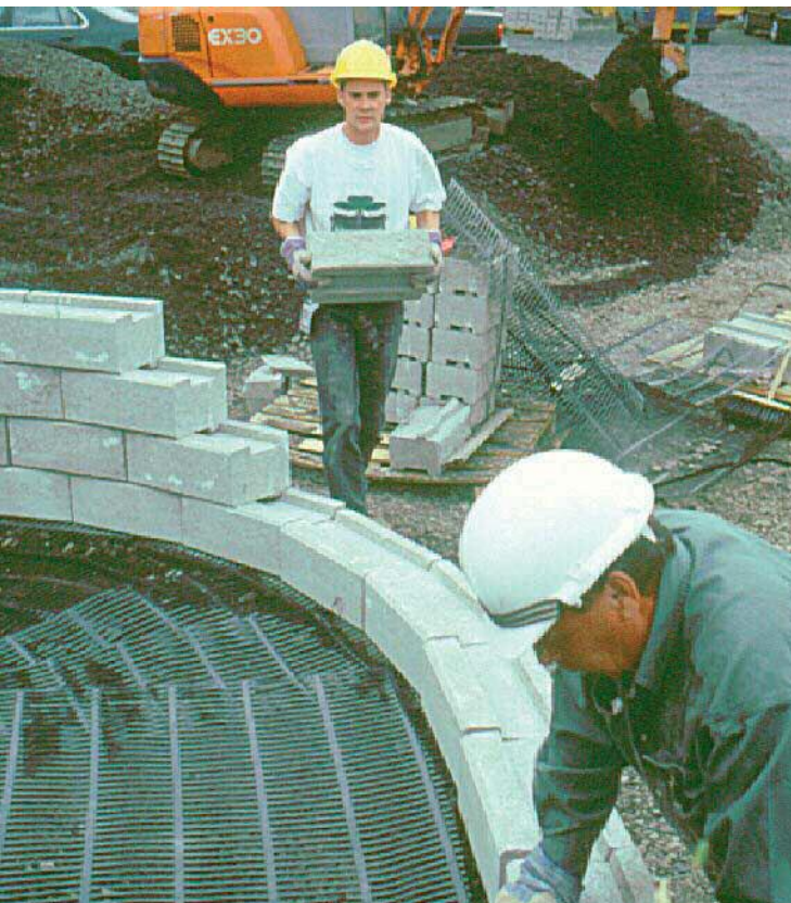
Gạch Block TW1 được đặt trên các pallet để đưa đến vị trí lắp đặt và có thể liên kết chặt chẽ với nhau hoặc tạo đường cong cho mặt tường.
