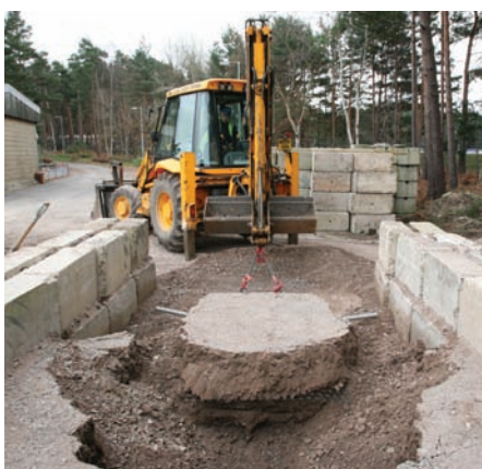
Đánh giá sự hư hỏng khi thi công lưới TriAx được thực hiện ở TRL.
