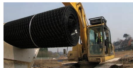
Lưới TriAx có thể dễ dàng được nâng bằng máy hoặc được khuôn vác bởi 2 công nhân
