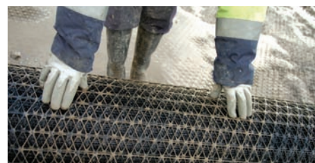
Lưới TriAx được trải ra trên công trường
