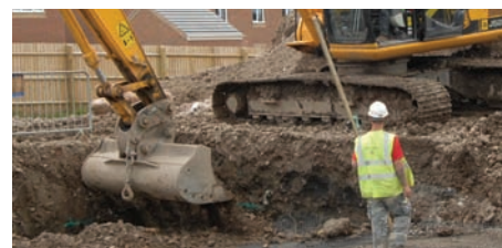
Vật liệu đắp được trải trên lưới TriAx trước khi lu lèn.
